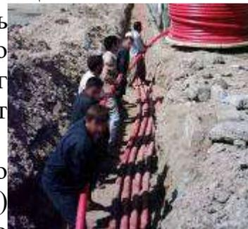
Кабели с несовпадающими осями одинаково расцвеченных жил при монтаже (или ремонте) подкручивают вокруг оси, пока не будет зафиксировано точное совпадение осей жил. Однако сильное подкручивание не безопасно. Оно вызывает механические напряжения в защитных и изоляционных покровах кабелей и влечет за собой снижение надежности в работе.
