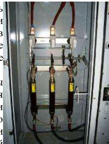
Аппараты и шины распределительных устройств должны быть динамически устойчивы к токам короткого замыкания. Это значит, что они должны выдерживать динамические усилия, вызванные прохождением через них наибольшего (ударного) тока короткого замыкания, соответствующего начальному моменту возникновения тока короткого замыкания, возможного в данном распределительном устройстве.
