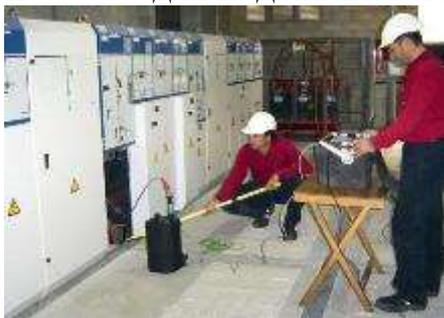
Длительное превышение температуры токоведущих частей сверх допустимого нормами запрещается. Такой режим влечет за собой увеличение переходного сопротивления в соединениях токоведущих частей оборудования, что в свою очередь ведет к дальнейшему повышению температуры контактного соединения с последующим увеличением переходного
